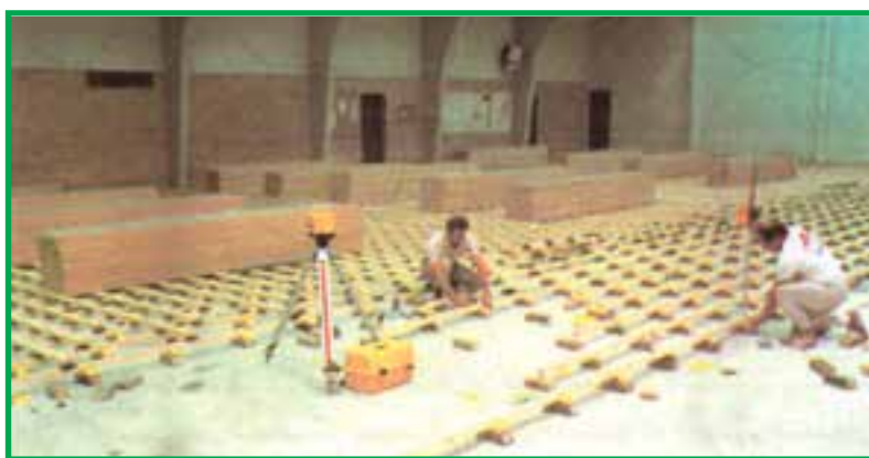
شکل ۳-۵- طریقه زیرسازی جهت نصب پارکت
