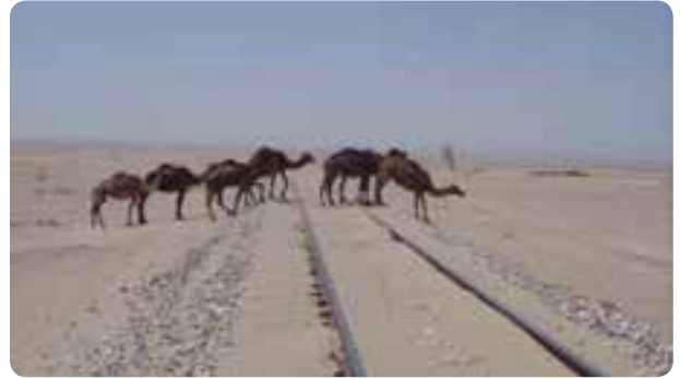
شکل ۱-۴۴- هجوم ماسه‌های روان به خطوط راه آهن در مسیر بافق
