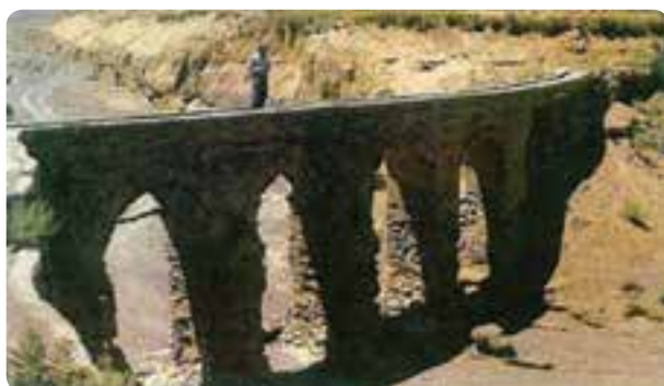
شکل ۳۴-۱- پل انتقال آب قنات بر روی رود دوکالی خراق
