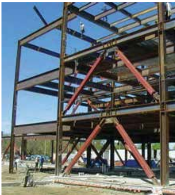
شکل ۵۰-۳- مقاوم سازی ساختمان‌ها در مقابل زمین لرزه
