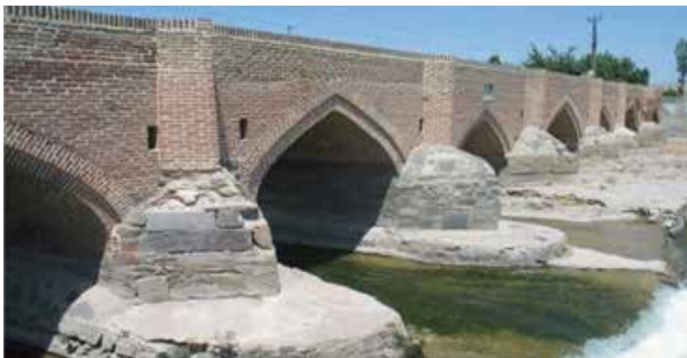
شکل ۸-۴- پل هفت چشمه اردبیل از دوره صفویه
