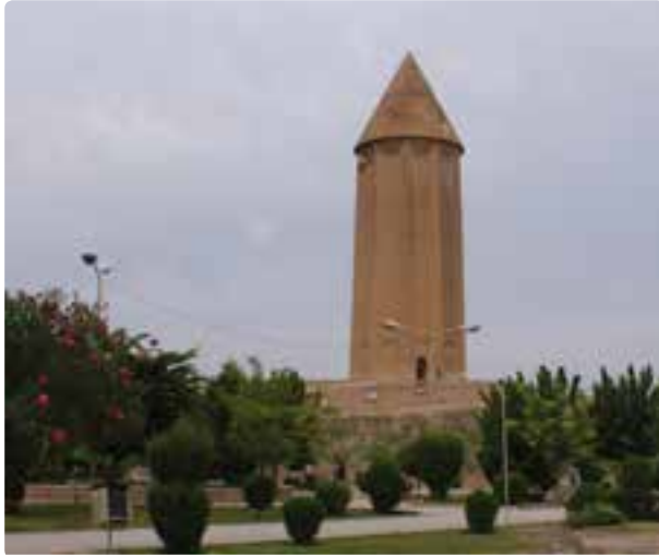
شکل ۴۰-۵- برج آجری قابوس بن وشمگیر - گنبد کاووس
