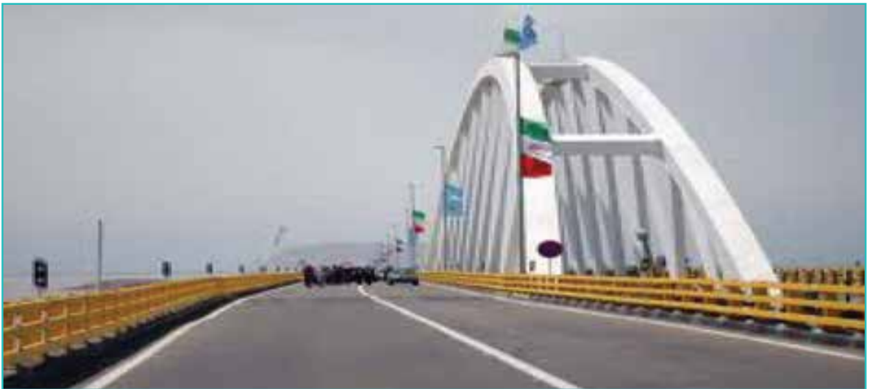
شکل ۶-۶- پل میان گذر دریاچه ارومیه
