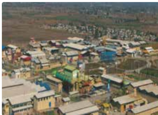
شکل ۲-۴- شهرک صنعتی علی آباد
