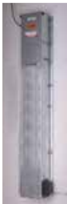
شکل ۲۶-۳- دماسنج کنترل‌کننده پمپ آب
