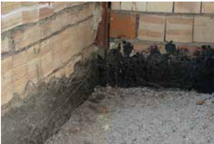
تصویر ۱۶ - عایق‌کاری کف سرویس بهداشتی
