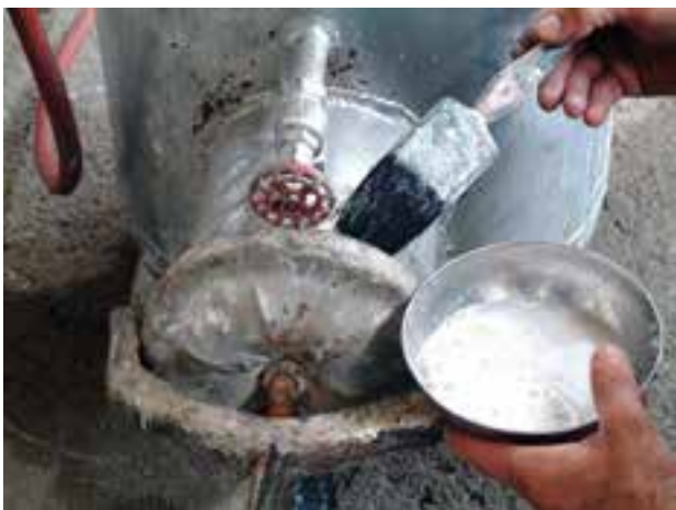
شکل ۲-۳۹- کنترل نشتی گاز
