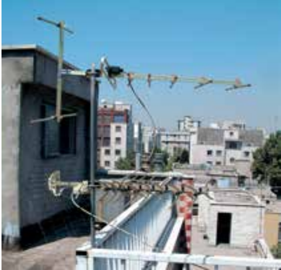
شکل ۱-۶۹- آنتن VHF و UHF روی دکل
