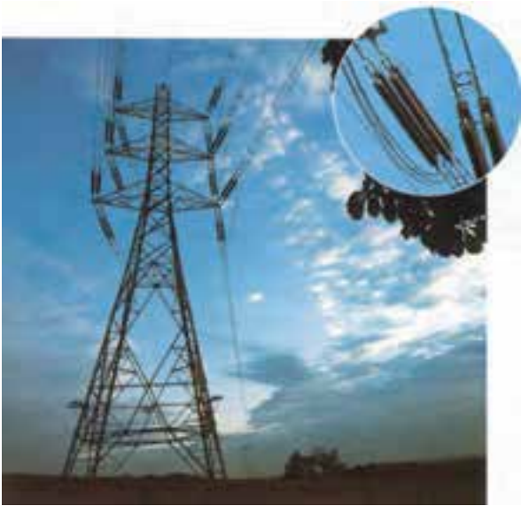
شکل ۱۹-۳- سیم های رابط خطوط انتقال باید دارای مقاومت کمی باشند. مقاومت این سیم ها از نوع مقاومت های مزاحم است.
