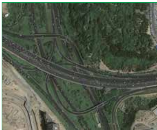
شکل ۱۴-۱ - عکس هوایی از پل فجر تهران (تقاطع بزرگراه‌های مدرس و همت)
