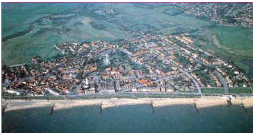
شکل ۷- احداث حفاظ در سواحل ماسه‌ای
