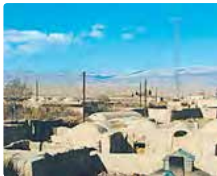
شکل ۴۱-۲- سقف خانه‌ها در مناطق گرم - سمنان
