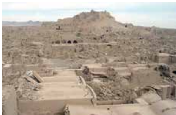
ب- ارگ بم بعد از وقوع زلزله
