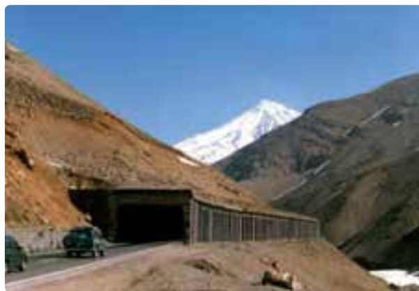
شکل ۲۵-۶- بهمن گیر راهی برای مقابله با خطر بهمن - جاده هراز
