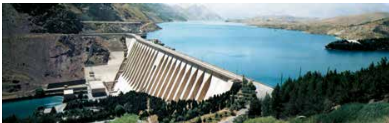
شکل ۲۶-۶- احداث سد روشی برای کاهش خطر خشک‌سالی
