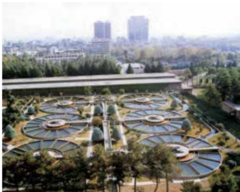
شکل ۱۲-۹- تصفیه‌خانه شماره ۲ آب تهران - جلالیه
