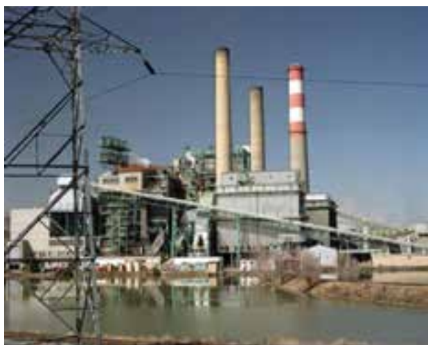
شکل ۲- نمایی از یک نیروگاه گازی
