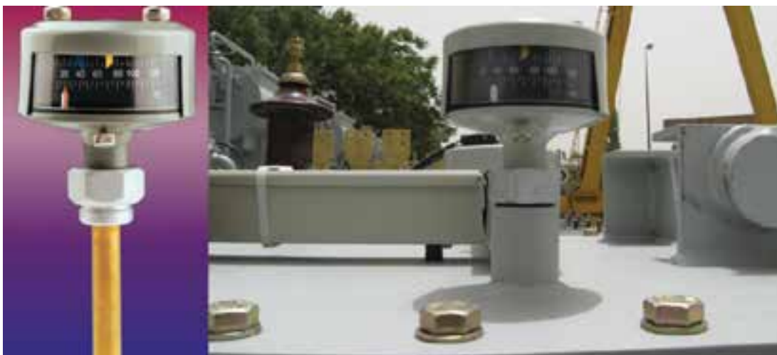
شکل ۲۳- ترمومتر ساده کنتاکت دار و محل نصب آن روی مخزن ترانسفورماتور
