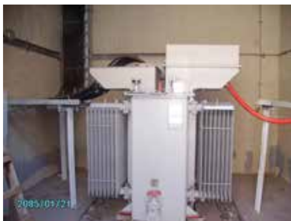
الف) ترانسفورماتور با جعبه ترمینال
