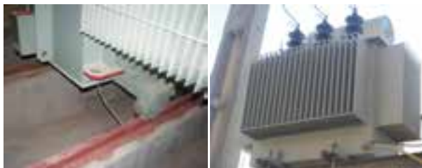
شکل ۳۷- محل اتصال سیم زمین
