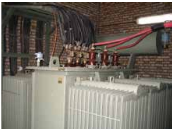
ب) ترانسفورماتور بدون جعبه ترمینال
