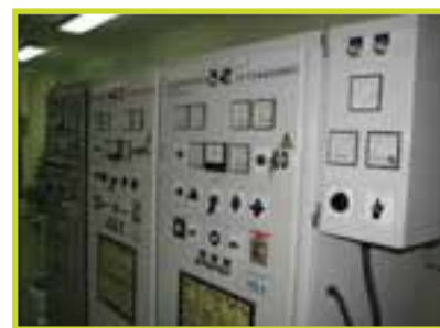
شکل ۱۲- تابلوی فرمان سه مولد که با شبکه برق سراسری موازی شده اند
