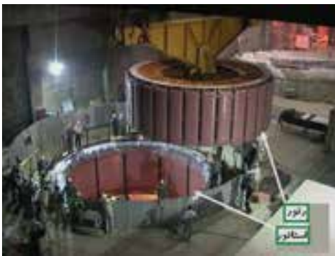
شکل ۸- رتور نیروگاه آبی سد شهید عباسپور در حال قرارگیری در استاتور
