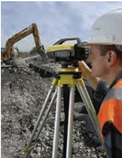
شکل ۱- ۱۴ اجرای تسطیح و کنترل حین اجرا
