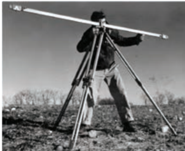
شکل ۵-۳- روش پارالاکتیک و شاخص آن
