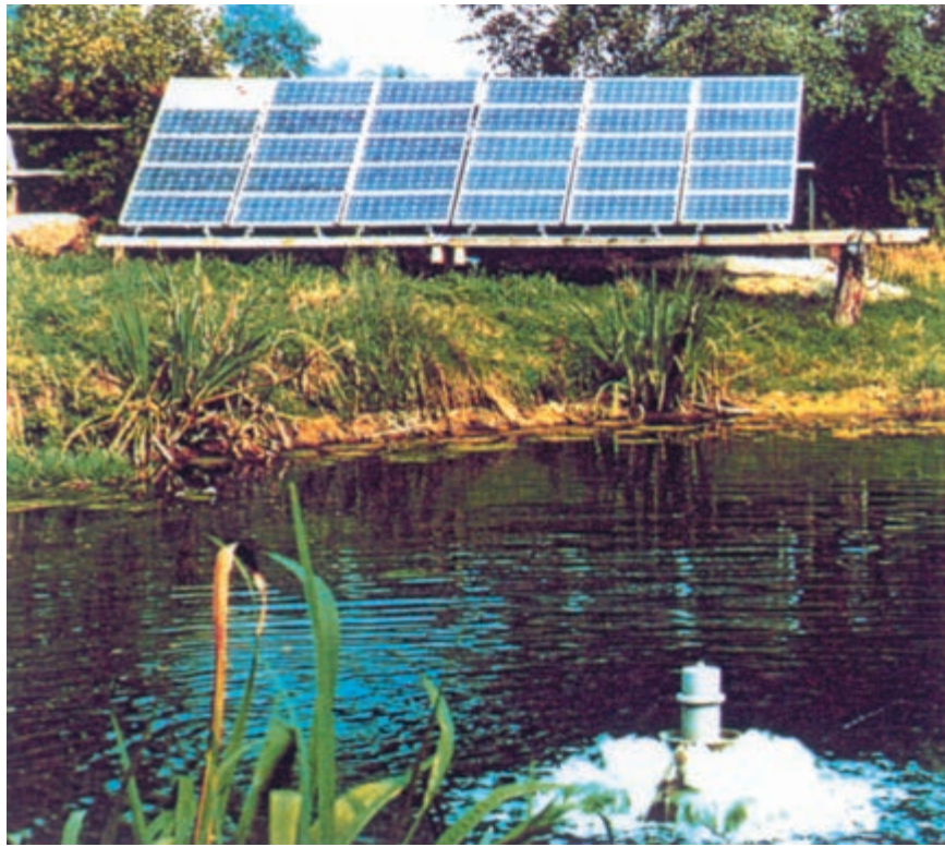
شکل ۷-۱۸- کاربرد پمپ‌های خورشیدی - تا سال ۱۹۹۷ میلادی در حدود ۲۰۰۰۰ پمپ خورشیدی در جهان نصب و راه‌اندازی شده است. در این پمپ‌ها انرژی خورشیدی به انرژی الکتریکی DC یا AC تبدیل می‌شود. توان کارکرد پمپ‌های فتوولتائیک به مقدار انرژی خورشیدی در منطقه بستگی دارد.
