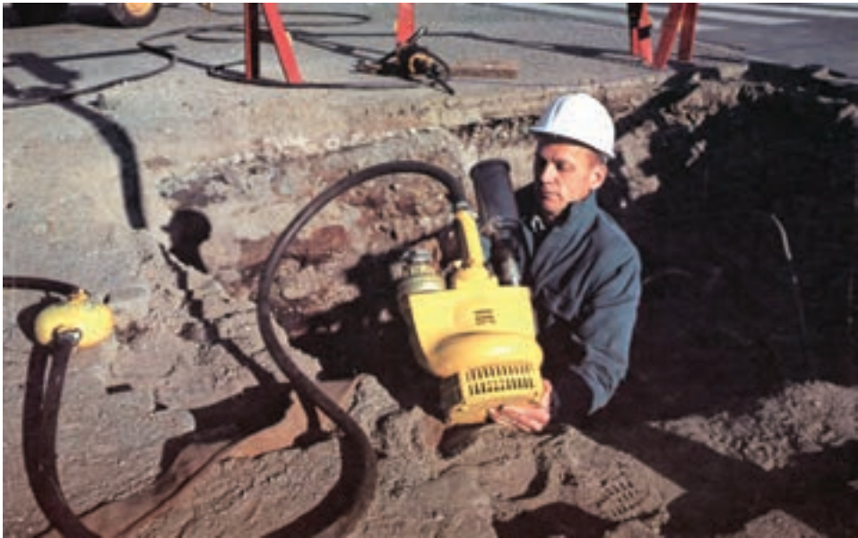
شکل ۱۸-۶- استفاده از پمپ با هوای فشرده
