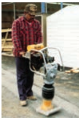
شکل ۵-۱۰- ماشین آلات متناسب با روش های کوبیدن خاک.
