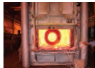
شکل ۲-۴۳ کوره عملیات حرارتی کارگاهی
