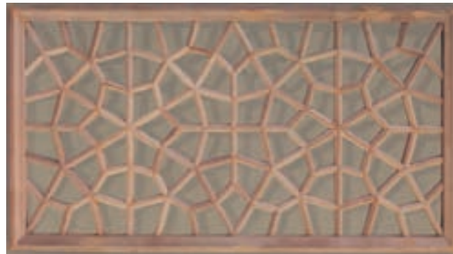
شکل ۹-۸۸- اتصال متقاطع در گره چینی یک پنجره.
