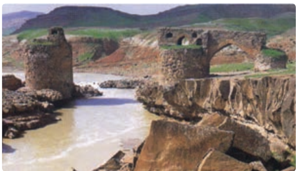
شکل ۲۹-۵- پل گاومیشان دره شهر
