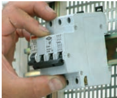
شکل ۸-۲- طرز قرارگیری فیوز مینیاتوری روی ریل
