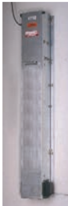
شکل ۲۶-۳- دماسنج کنترل‌کننده پمپ آب
