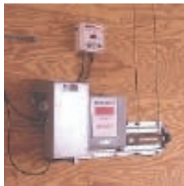
شکل ۳-۲۳- کنترل خودکار هواکش‌ها
