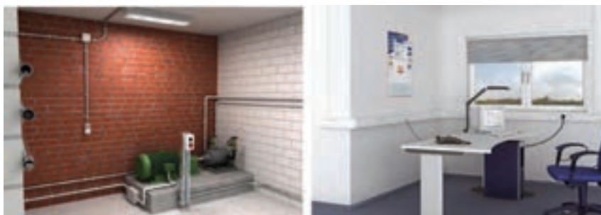
ب) سیم کشی داخل لوله
