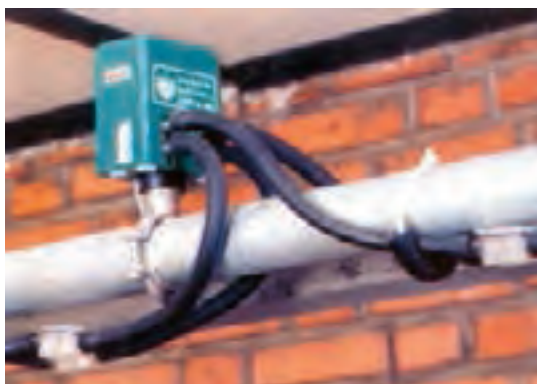
شکل ۴۰-۴ — دستگاه نبض‌ساز
