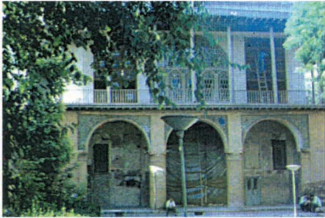
شکل ۱۲۱- عمارت چهلستون قزوین
