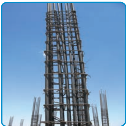
شکل ۱۹-۷- کار گذاشتن میلگردهای انتظار ستون، در فونداسیون
