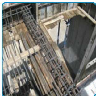
شکل ۷-۳۱- اجرای بازشودر سقف
