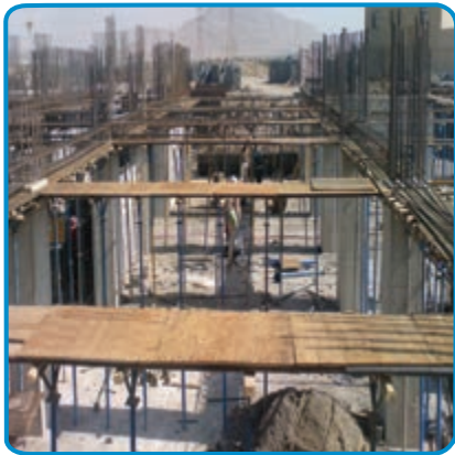
شکل ۷-۲۱- قالب بندی تیرها
