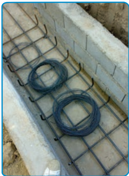
شکل ۹-۷- بهم بستن میلگردها
