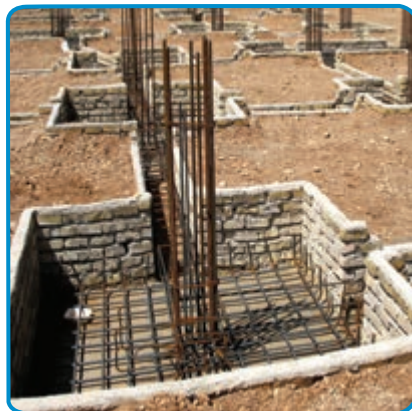
شکل ۴-۷- اجرای میلگردهای ریشه انتظار
