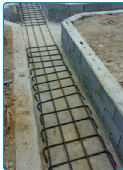
شکل ۸-۷- چیندن میلگردهای طولی و عرضی
