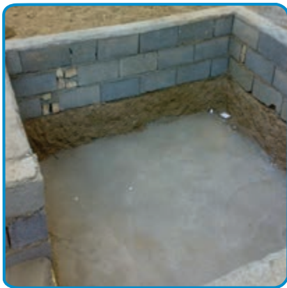
شکل ۱-۷- آماده سازی کف پی
