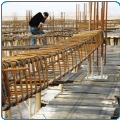
شکل ۷-۲۴- تنظیم فاصله بین خاموت ها
