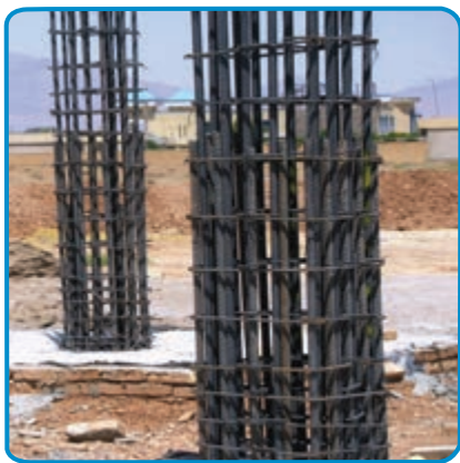
شکل ۱۶-۷- بتن ریزی ستون
