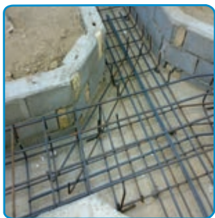
شکل ۱۳-۷- قرار دادن میلگردهای تقویتی پنجه ها
