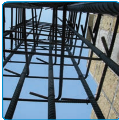
شکل ۱۹-۷- کار گذاشتن میلگردهای انتظار ستون، در فونداسیون
