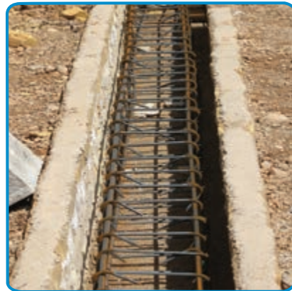
شکل ۵-۷- اجرای میلگرد شناژها
