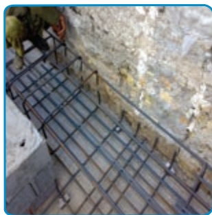
شکل ۱۲-۷- میلگردگذاری شبکه بالای
