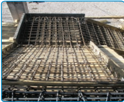
شکل ۳۷-۷- اجرای میلگردهای دال پله
