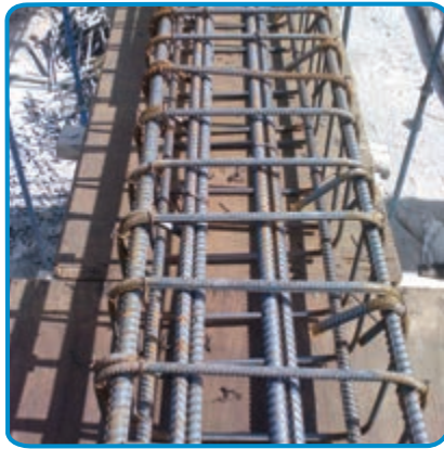
شکل ۷-۲۵- بستن خاموت ها با مفتول
