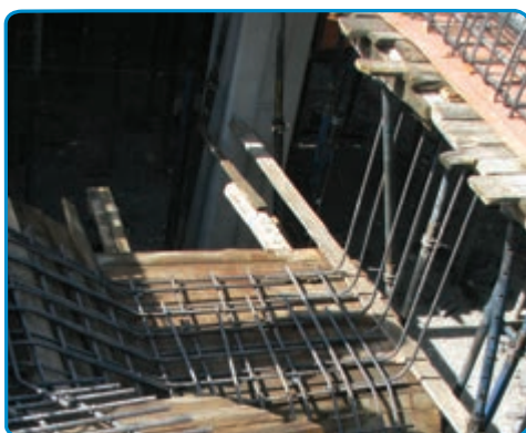
شکل ۴۱-۷- اجرای میلگردهای دال پله
