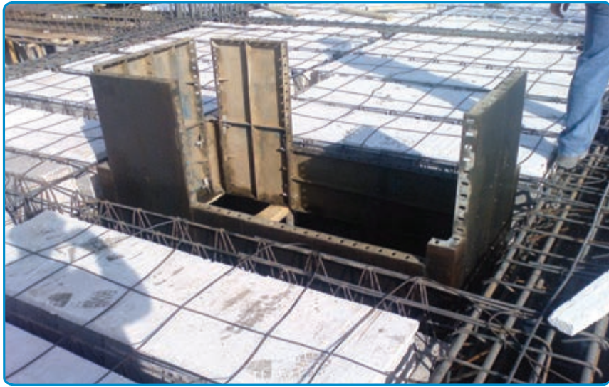
شکل ۳۵-۷- تکمیل قالب بندی
