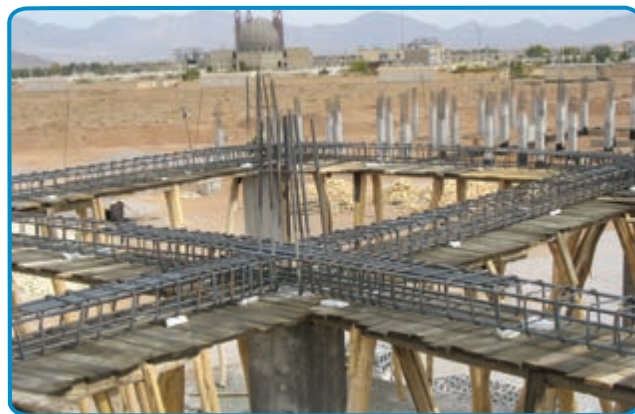
شکل ۷-۲۷- رعایت فاصله پوشش بتنی در کف
