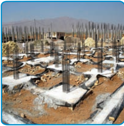
شکل ۱۷-۷- اجرای خاموت و سنجاقک
