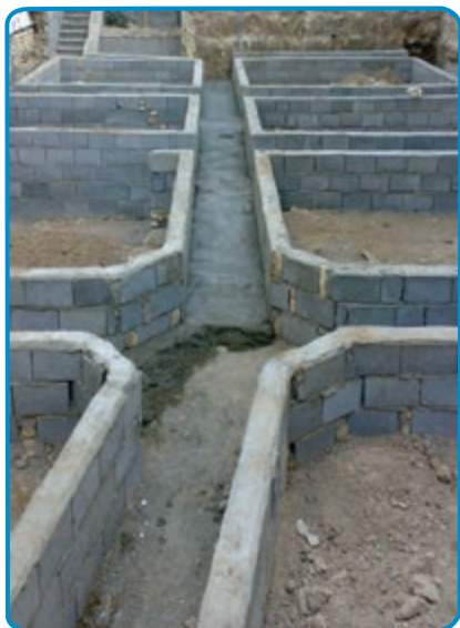
شکل ۶-۷- آماده سازی کف پی
