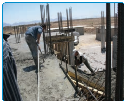
شکل ۴۲-۷- بتن ریزی دال پله
