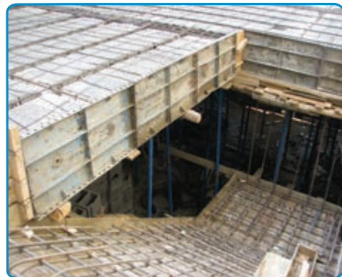
شکل ۴۰-۷- اجرای میلگردهای دال پله
