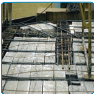
شکل ۷-۳۲- اجرای تیرهای فرعی کنسول
