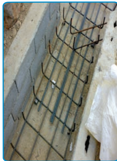
شکل ۱۱-۷- قرار دادن میلگردهای تقویتی
