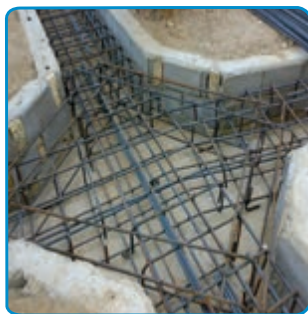
شکل ۱۴-۷- تکمیل میلگردگذاری محل اتصال ستون
