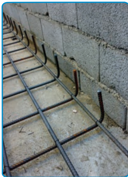
شکل ۱۰-۷- رعایت پوشش بتن در کف و بدنه
