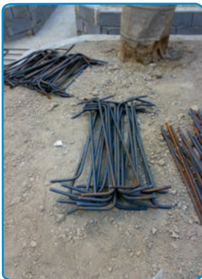
شکل ۷-۷- آماده کردن میلگردهای طولی و عرضی
