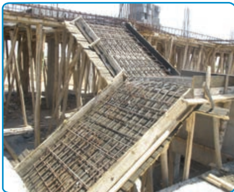
شکل ۳۹-۷- اجرای میلگردهای دال پله
