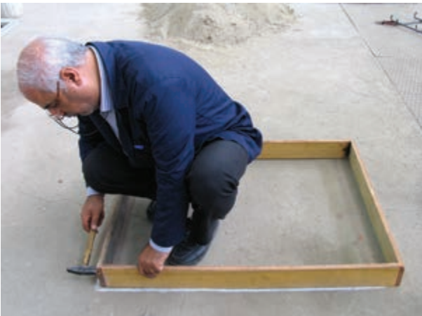
شکل ۴-۱- قالب بندی فونداسیون
