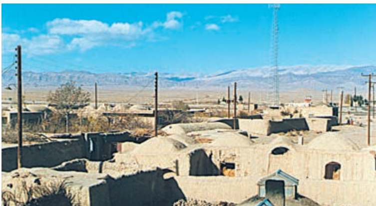
شکل ۴۱-۲- سقف خانه‌ها در مناطق گرم - سمنان
