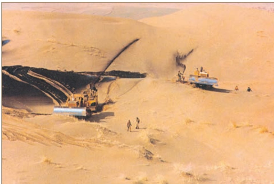
شکل ۱۱-۳- پاشیدن مالچ نفتی بر روی ماسه‌های روان
