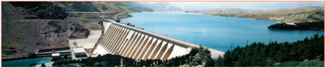
شکل ۲۸-۶- احداث سد روشی برای کاهش خطر خشک‌سالی
