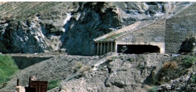
شکل ۲۷-۶- دو نوع بهمن گیر در جاده هراز، راهی برای مقابله با خطر بهمن
