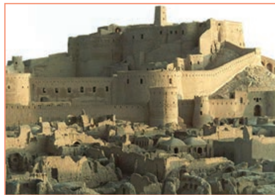
الف) ارگ بم قبل از وقوع زلزله
