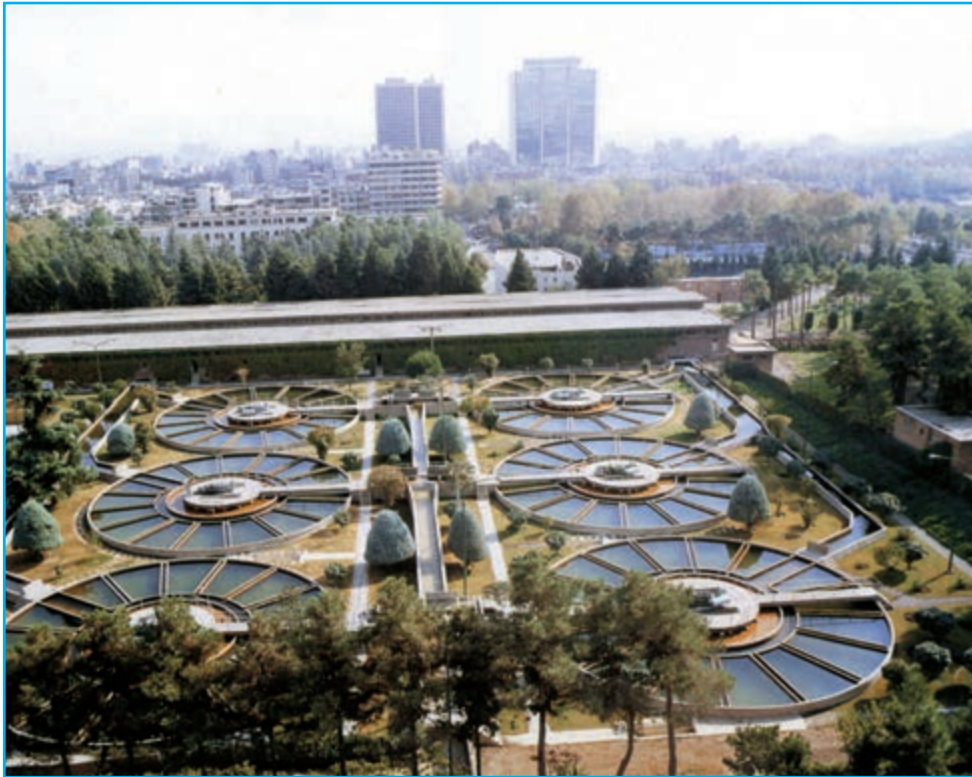
شکل ۱۴-۹- تصفیه خانه شماره ۲ آب تهران - جلالیه
