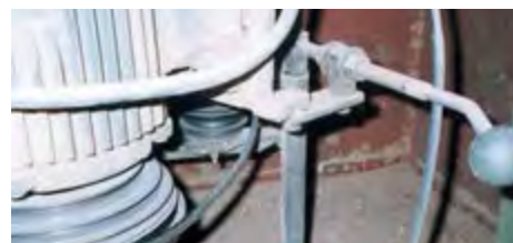
شکل ۳-۱۴. باز کردن درپوش روی تسمه‌ها.
