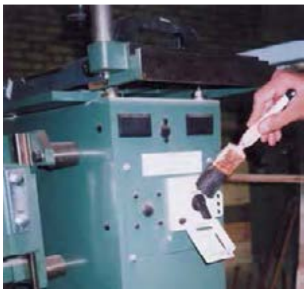
شکل ۱۵-۱- گردگیری و تمیز کردن کلید برق.
