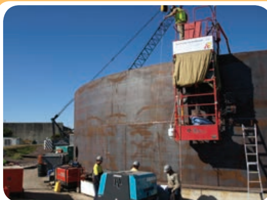
م) کارگاه ساخت مخازن ذخیره
