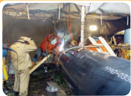
ن) کارگاه ساخت خط لوله
