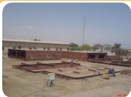
د) کارگاه ساخت اسکلت فلزی ساختمان
