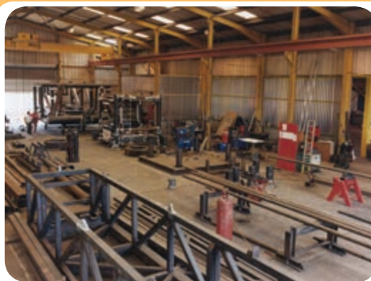
الف) کارگاه ساخت سازه‌های ساختمانی
