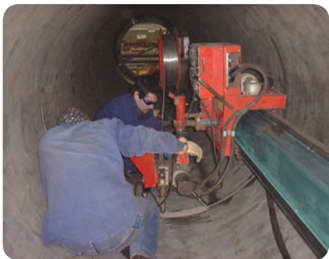
اتصال دو لوله فولادی با استفاده از فرآیند جوشکاری زیر پودری
