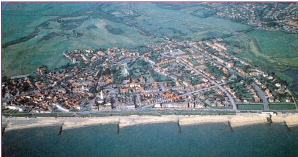
شکل ۷- احداث حفاظ در سواحل ماسه‌ای
