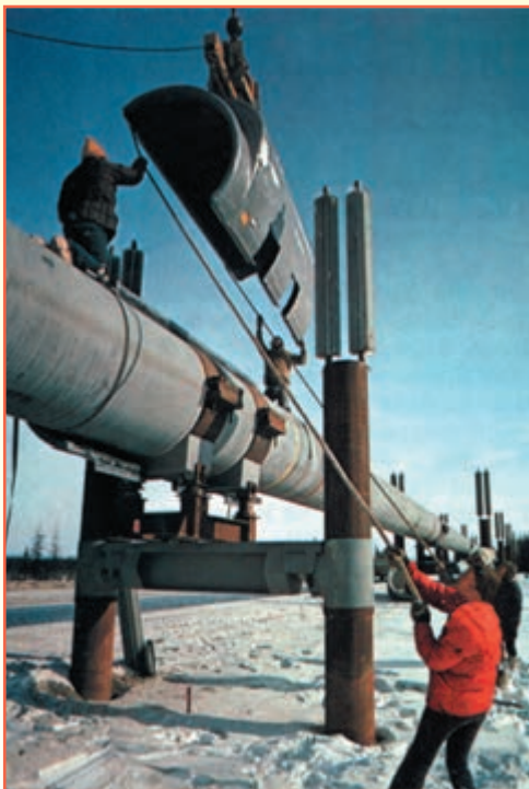
شکل ۶- لوله‌های نفت در داخل جدار گرم‌کننده و بر روی پایه‌ها نصب می‌شود تا از یخ‌زدن آن جلوگیری کند.
