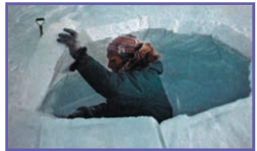
شکل ۴-ب- مراحل ساختن یک ایگلو
