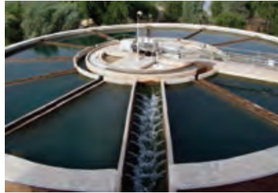
آب در تصفیه‌خانه
