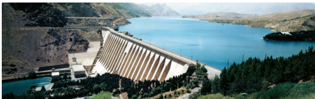
شکل ۲۶-۶- احداث سد روشی برای کاهش خطر خشک‌سالی
