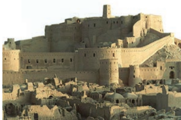
الف- ارگ بم قبل از وقوع زلزله
