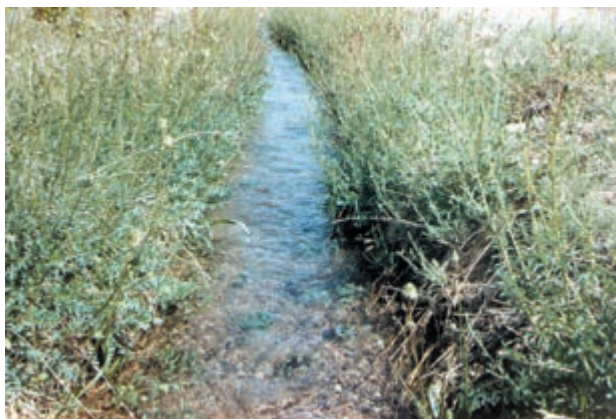
شکل ۱۵-۲- نهر زراعی بدون پوشش
