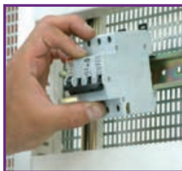
طرز قرارگیری فیوز روی ریل
